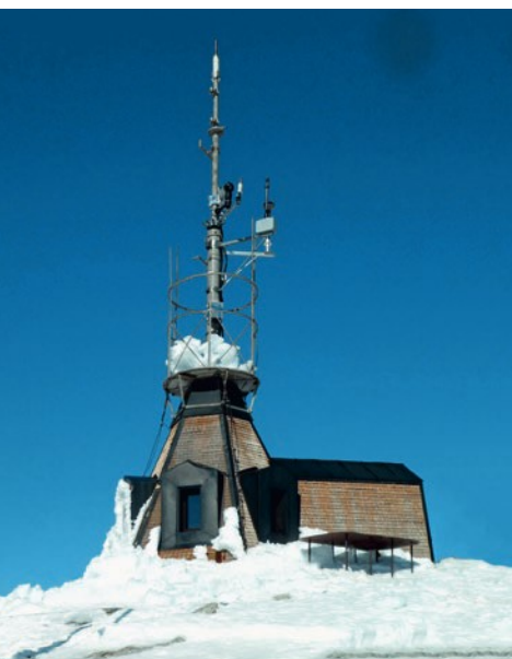
Wetterstation auf dem Säntis (2'502 m ü.M.) – 1882 erbaut und über Telegraphenleitung mit dem Tal verbunden
