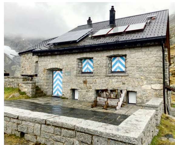
Die Hütte, bereit für den Winterschlaf, am 22. Oktober 2023
