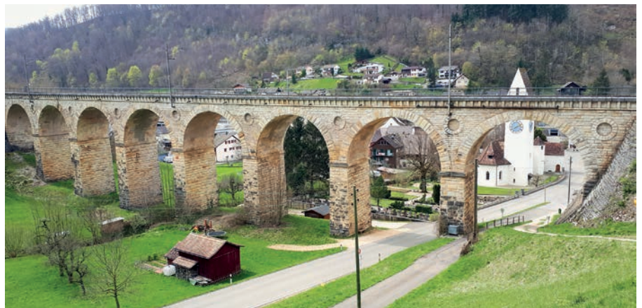
Mauerwerkviadukt in Rümelingen, errichtet 1856
