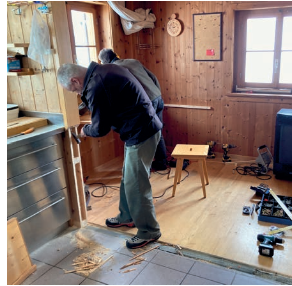
Umbauarbeiten Küche 23. Mai 2023
