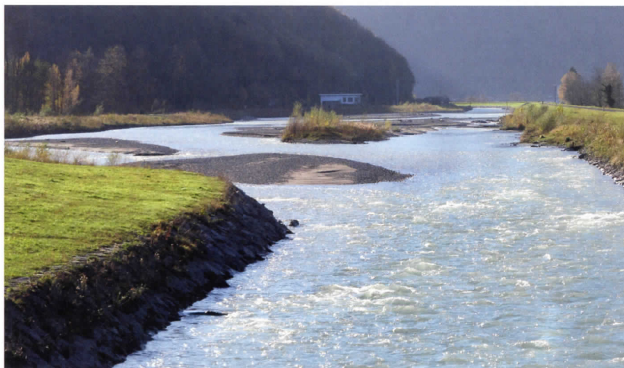
Neu geschaffene Aufweitung des Escherkanals bei Gäsitschachen, zwischen Mollis und Walensee
